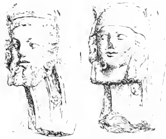
20. — Maison rue du Vieux-Bourg à Gand.
